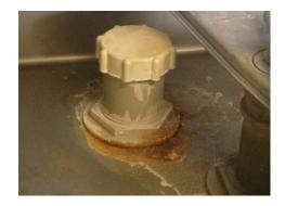
Foto: Falsche Handhabung durch Salzbefüllung nach Betriebsschluss, ohne nachgelagertem Spülgang.
